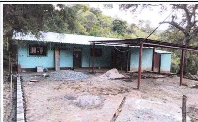
Foto 2: Mejoramiento instalacion piso torta de cemento.
