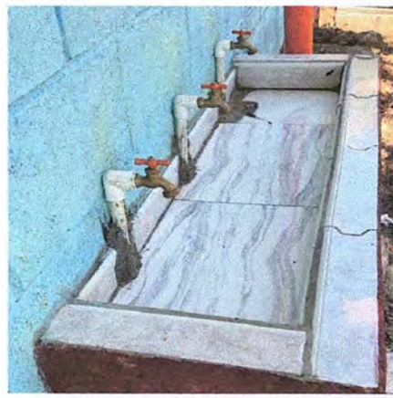
Foto 4: Mejoramiento e instalacion de lavamanos juntos a la base del tinaco.
