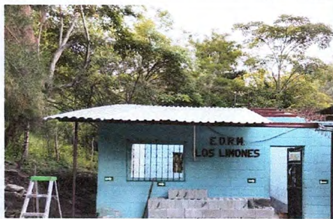
Foto 3: Mejoracion instalacion cambio de techo.
